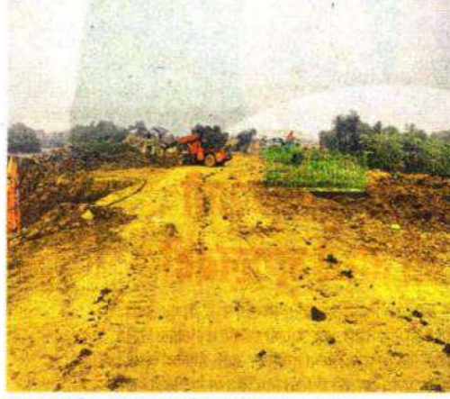
खारघर : तळोजा-खारघर खाडीवरील पुलामुळे काम सुरु आहे.
